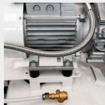
Gruppo pompante montato su dispositivi antivibranti
